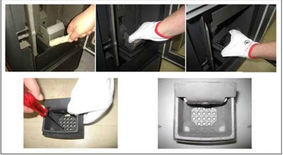
Şekil 17: Yanma hücresi ve yanma haznesi temizliği
