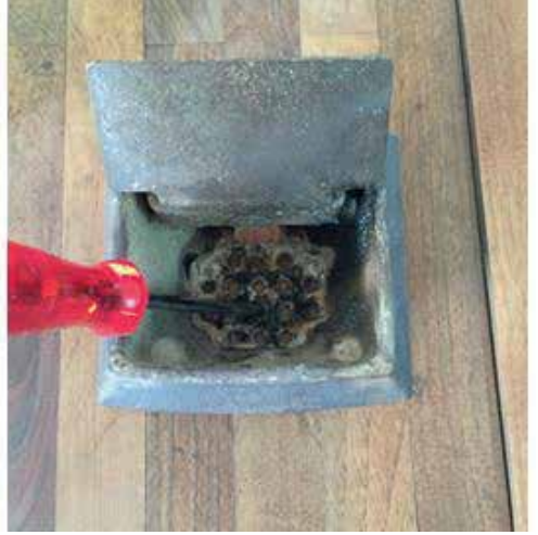
Şekil 15 B: Kirli yanma hücresi
